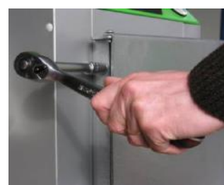
Fot.8. Przykręcić śruby montażowe zawiasów
