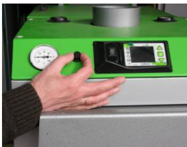
Fot.1. Odkręcić nakrętkę zaślepiającą ogranicznika STB.
