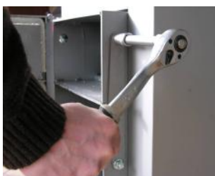
Fot.10. Zamontować rygiel po drugiej stronie.
