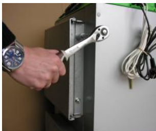
Fot.7. Zdemontować drzwiczki z włazu.
