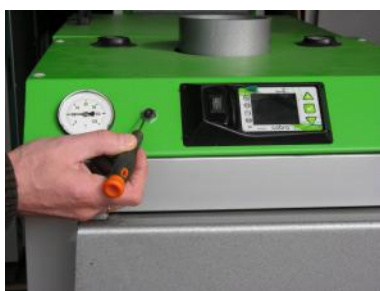
Fot.2. Śrubokrętem wcisnąć przycisk odblokowując regulator.
