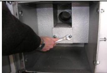
Fot.2. Odkręcić nakrętki pokrywy wyczystki komory powietrznej.
