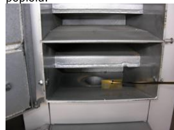
Fot.6. Pozostałości pyłu zgarnąć gracą do otworu paleniska.
