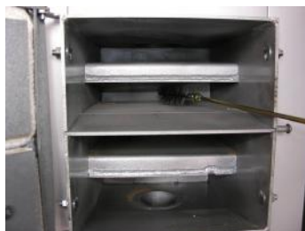
Fot.5. Powierzchnie wymiennika czyścić szczotką.
