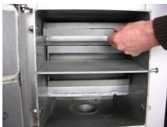
Fot.4. Wyjąć turbolizery spalin /12 i 18 kW/ i oczyścić je z pyłu.
